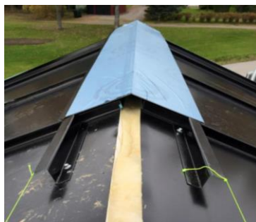
Figur 4, Nockplåt monterad på Z-profil
