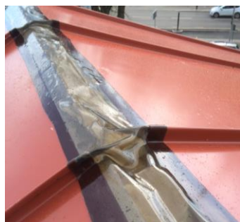
Figur 5, 3M Fast-UC monterad
