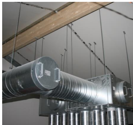
Figur 8, Upphängning av ventilation i Plustak
